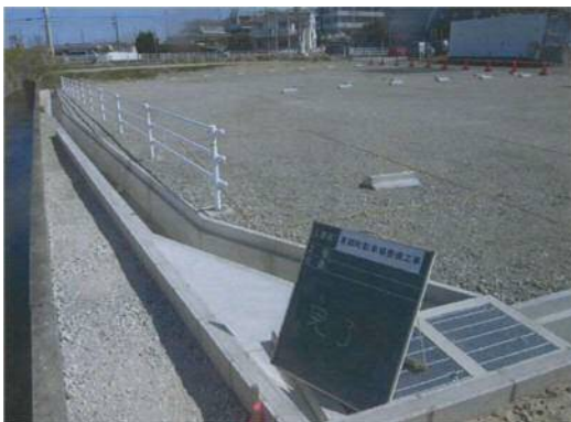
平成 28 年度整備が完了した施設 いこまい館（駐車場、表面貯留） （約 20m 3 ：東郷町）
