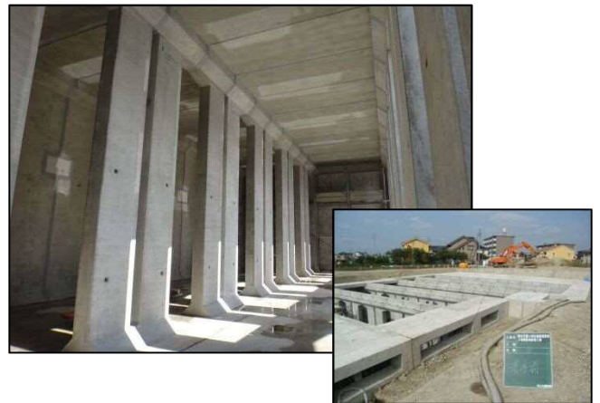
これまでに整備が完了した施設 豊田花園土地区画整理事業 （約 3,500m 3 ：豊田市）
