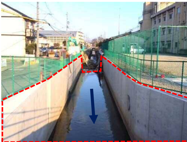
⑤原川：河道拡幅の状況
