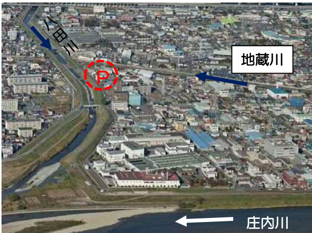
⑨地蔵川：排水機場建設予定箇所
