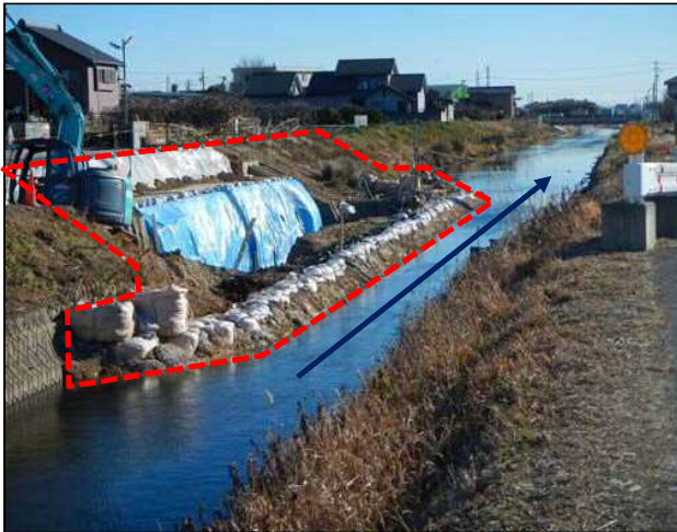
⑦合瀬川：護岸工施工状況
