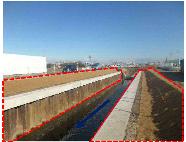
⑧鴨田川：護岸工施工状況
