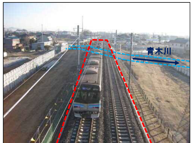
⑥青木川上流：名鉄犬山線橋梁施工箇所 (本線復旧完了状況)
