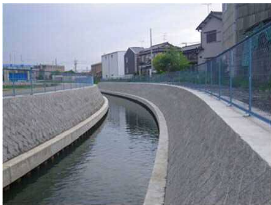
準用河川千間堀川改修（一宮市）
