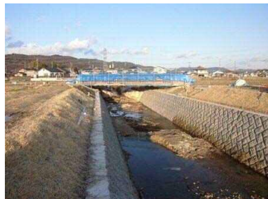
準用河川道木川改修（小牧市）
