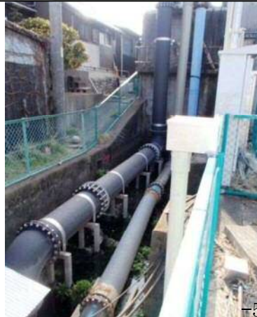
北名古屋市は、久地野ポンプ場の増強を行いました。平成27年3月より供用しており、今後の豪雨被害の軽減に効果が期待できます。（排水量：4.36m 3 /s→7.42m 3 /s）
