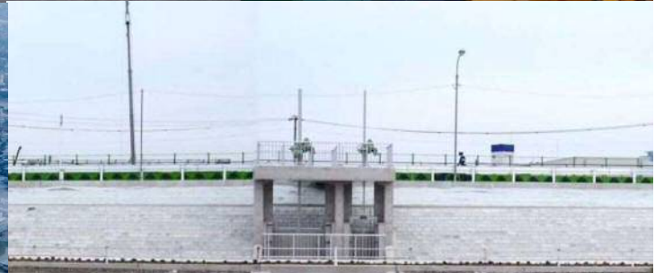
清須市は、芳野ポンプ場を新設しています。平成28年に供用開始する予定で、地域排水の改善期待できます。（排水量：6.22m 3 /s）
