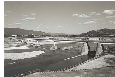
豊川用水事業により 松原用水と牟呂用水 の取水口を統合した 牟呂松原頭首工が 完成(S43年) 10
