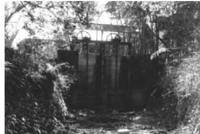
松原用水の旧取水施設 (一宮町松原地内)
