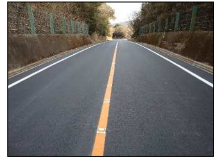
傷んだ路面を再舗装した農道 西幡地区（西尾市）
