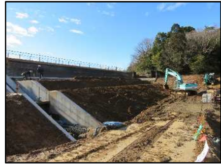
堤体耐震補強（石塚池：幸田町）
