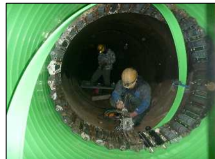
管更生工法にて更新される水路 将監2期地区（西尾市）
