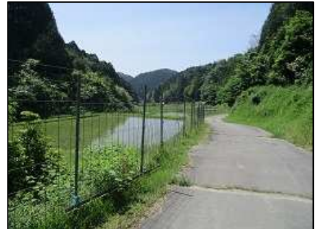
防護柵（岡崎市）
