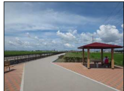
排水路沿いの水辺空間を活用した 遊歩道整備 中井筋2期地区（安城市）
