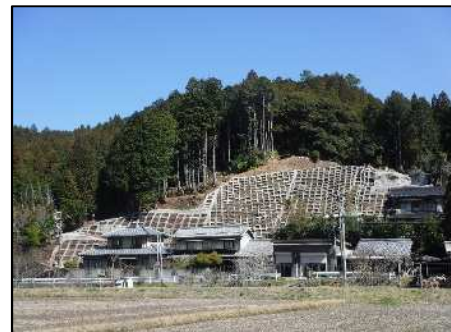
簡易法枠工（岡崎市）
