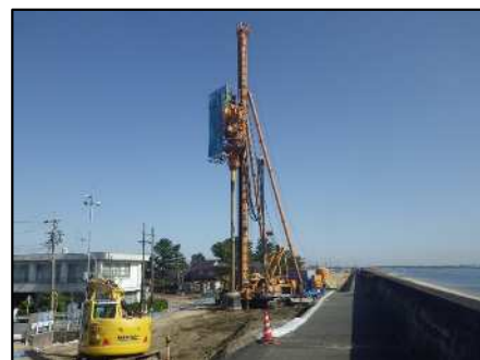
堤防耐震補強（碧南海岸：碧南市）
