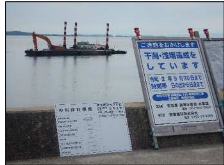
干潟・浅場造成工事
