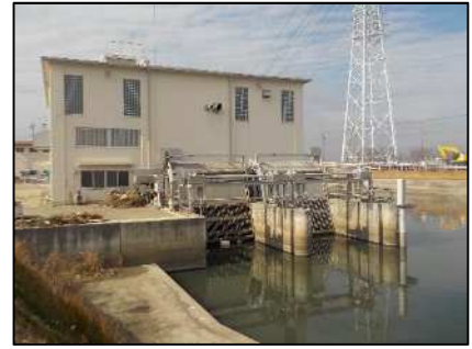
更新された北浜南部排水機場 北浜南部2期地区（西尾市）
