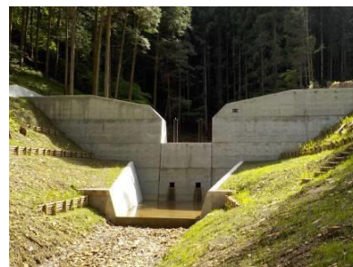
治山ダム工（東栄町）
