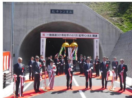
国道301号松平バイパス 松平トンネル 開通式 (2020年度)
