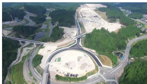
西工区完了写真（全景）
