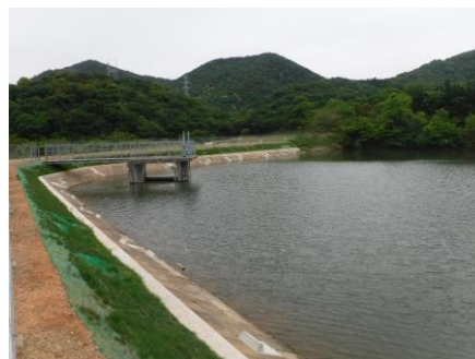
防災ダム事業 西宇利池地区（新城市）
