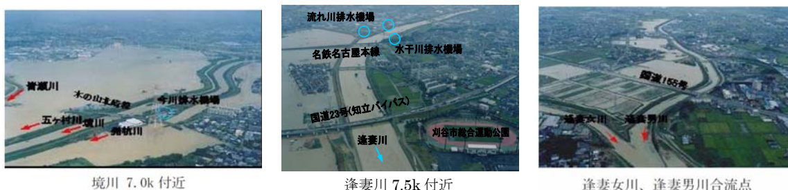
図 1.6 平成12年9月洪水被害状況
