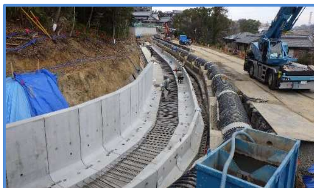
改修中の枝下用水幹線水路
