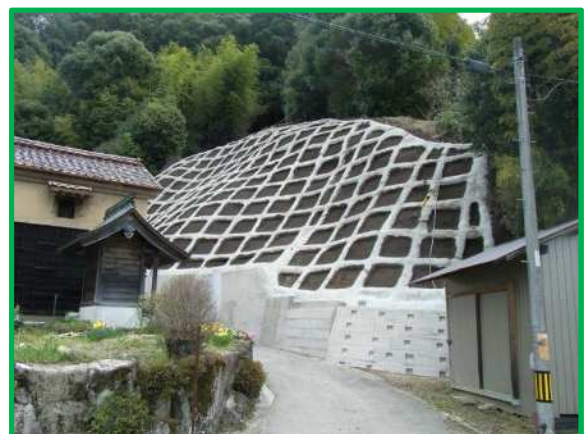
法面を安定化し災害を防止する法枠工
