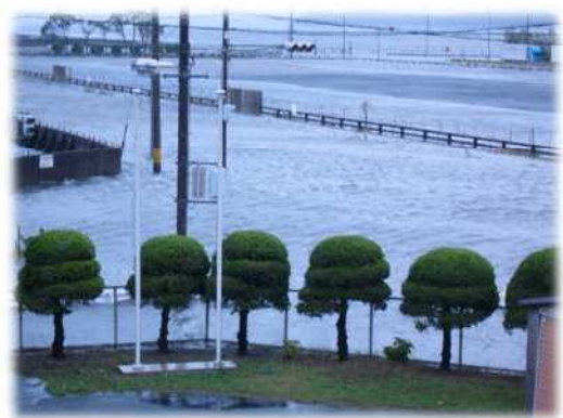
高潮による浸水（蒲郡地区）
