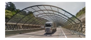
GPS精度低下区間の例(金属ネット)
