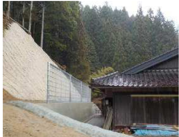
令和元年度 土留工、植生マット施工地 (豊根村)
