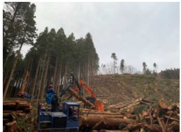
高性能林業機械3点セットによる連携作業 (豊根村下黒川)
