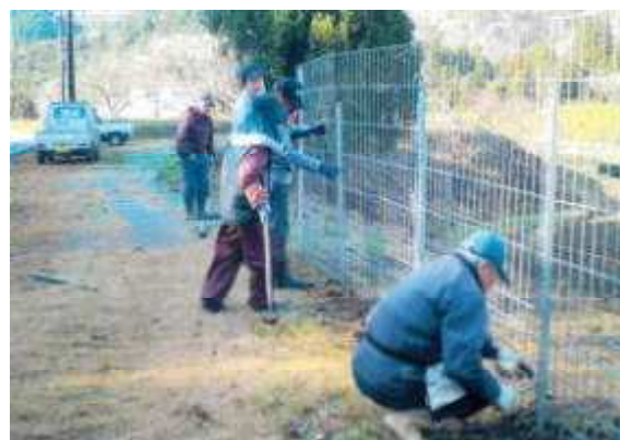
侵入防止柵の設置作業 (R1 新城市)
