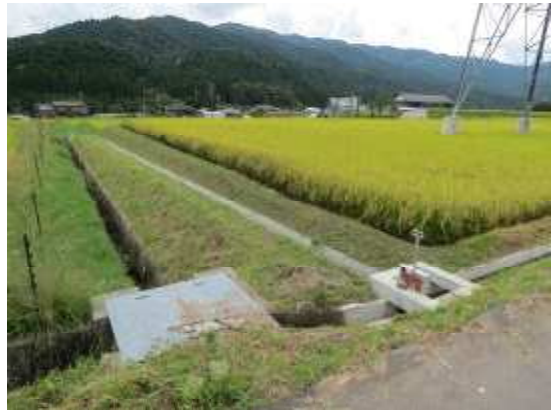
用排水路の整備 (設楽町西納庫)
