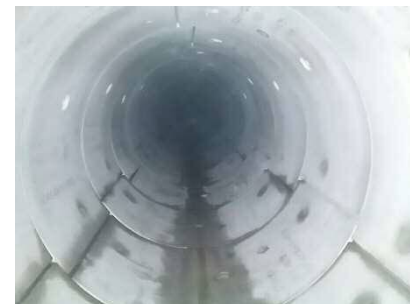
施工後(管きょ内部)
