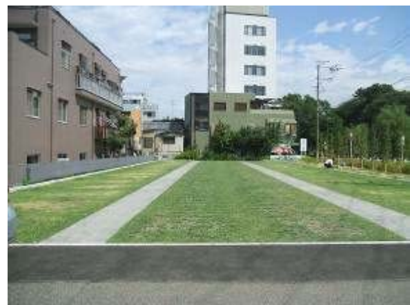
駐車場緑化（名古屋市）
