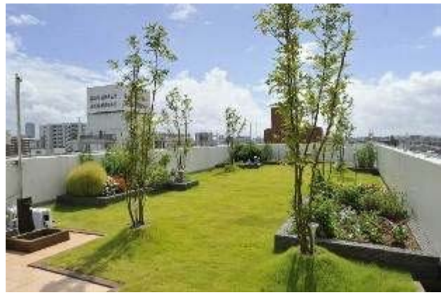
屋上緑化（名古屋市）
