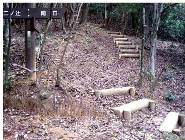
歩道、案内板設置
