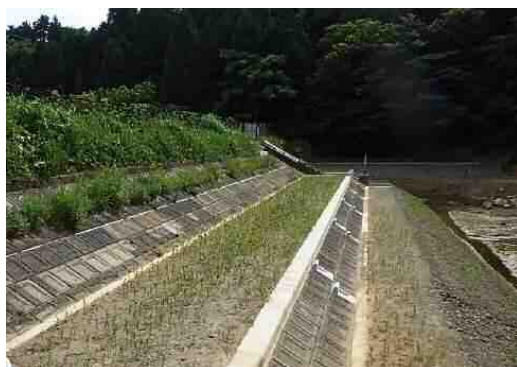
【宝谷池1号(幸田町)整備完了状況】
