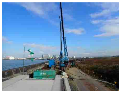
【豊橋杉山海岸 鋼矢板打設状況】
