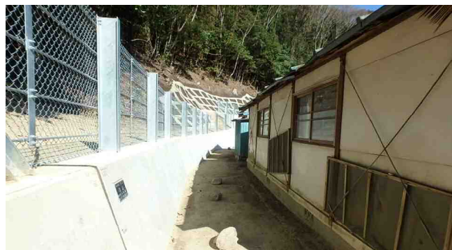
【治山施設の整備】
