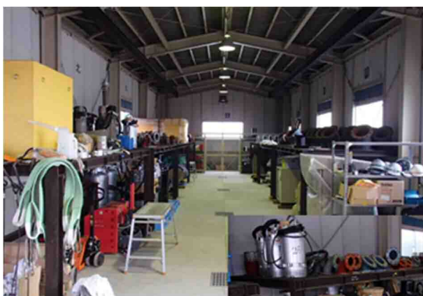
【災害応急用ポンプの準備状況】
