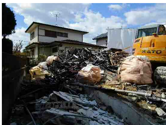
【解体工事現場の様子】
