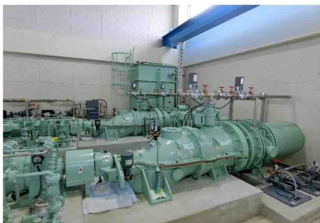
【整備完了状況】
