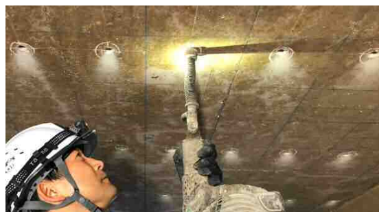
【幹線排水路の耐震対策工事(県営名古屋空港)】
