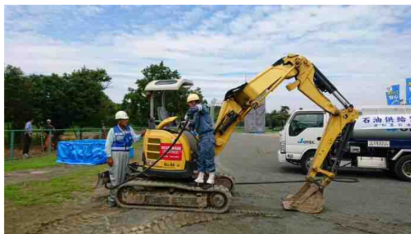
【重機への給油作業の様子】
