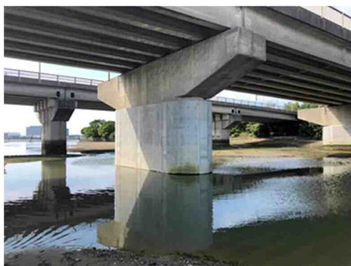
【(主) 豊橋渥美線・紙田川橋(下り)】
