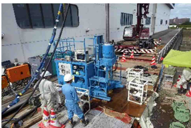
【排水機場の基礎の耐震化】
