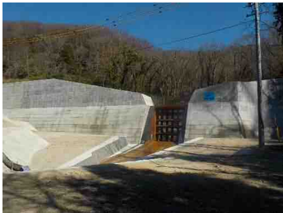
【砂防堰堤の整備】
