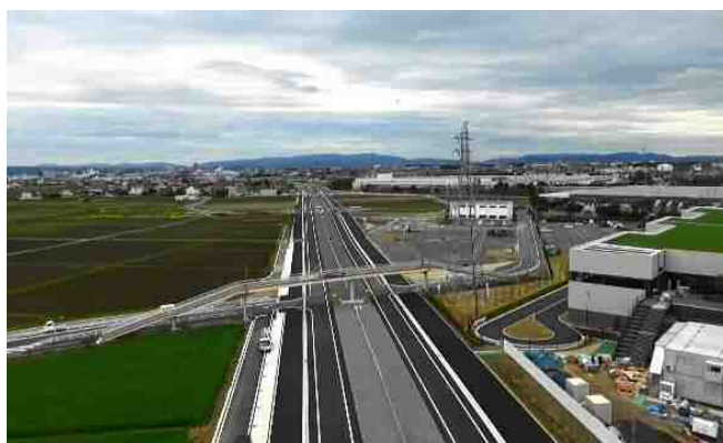
【(主) 名古屋岡崎線 豊田・安城工区】 (豊田市・安城市)
