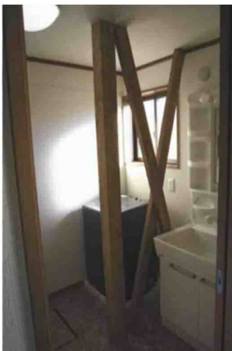
【住宅の耐震改修】
