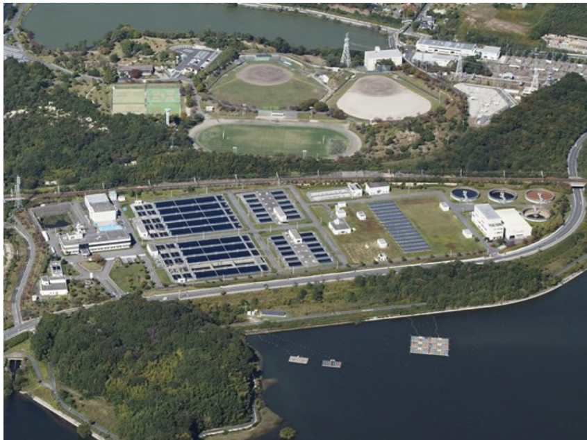
図 3 愛知池と尾張東部浄水場
