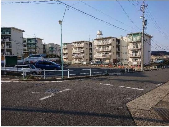
南方より調査対象地（12.4棟など）
