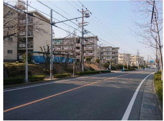
南東方より調査対象地（11-6棟など）
