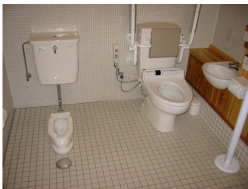
幼児用便器併設タイプの 多目的トイレ
