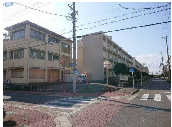
北東方より調査対象地 (集会所など)
