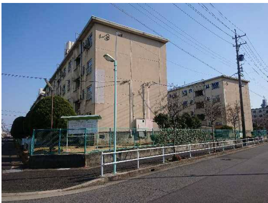
北西方より調査対象地 (1-3 棟など)
