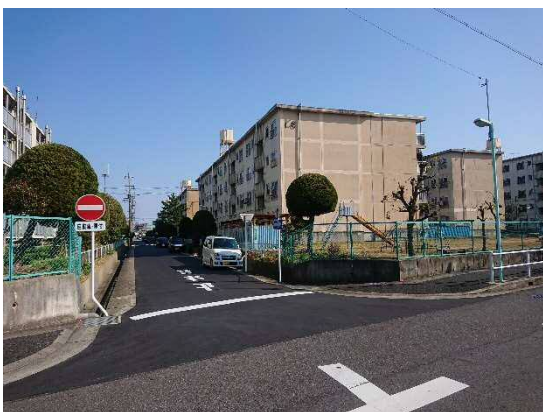
北西方より調査対象地 (1-6 棟など)
