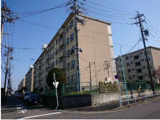
北西方より調査対象地 (1-1 西棟など)
