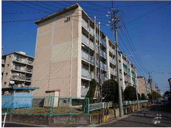
南西方より調査対象地（1-11 棟など）
