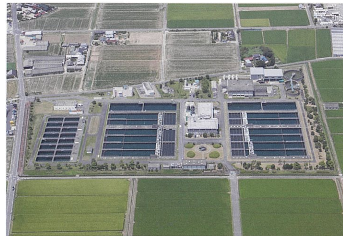
安城浄水場（平成30年8月撮影）
