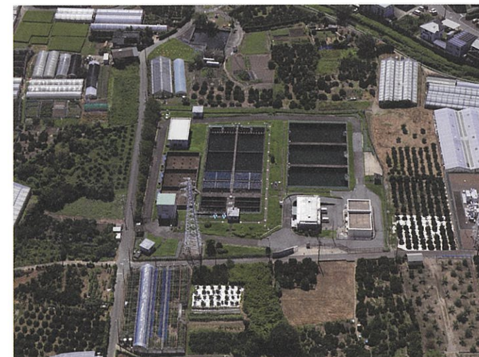
蒲郡浄水場(工水)（令和元年8月撮影）
