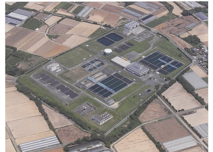
豊橋南部浄水場（平成30年8月撮影）
