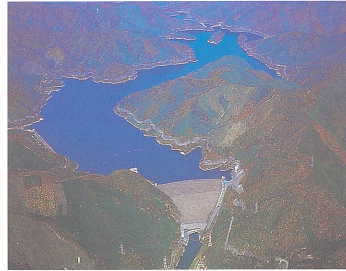
岩屋ダム (平成8年11月撮影)
