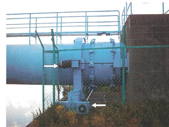
上部工落橋防止設備の事例（筏川第2水管橋）
