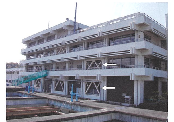
建物の耐震化事例（豊橋浄水場）
