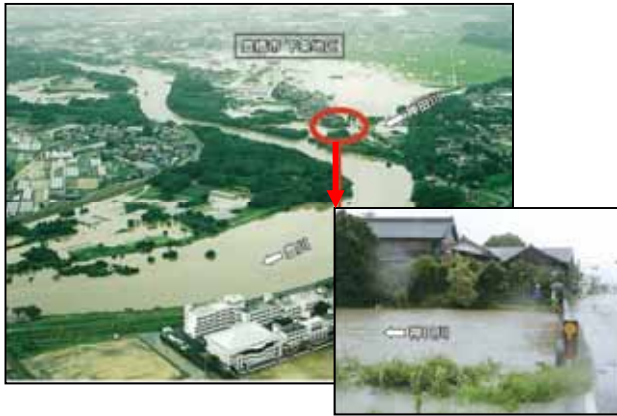
霞堤地区の浸水状況(平成15年8月:下条地区)
