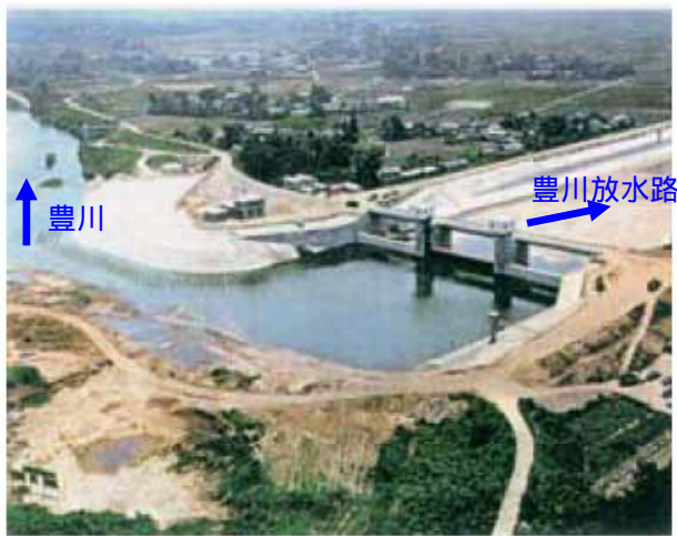
放水路建設時の状況
