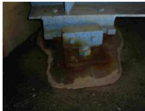
写真 10.1.3 橋座の滞水と桁端部の腐食
