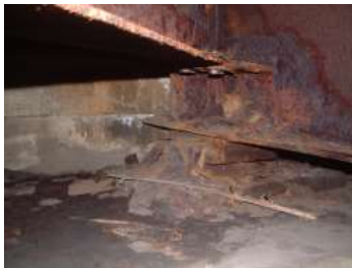
写真 10.1.3 橋座の滞水と桁端部の腐食
