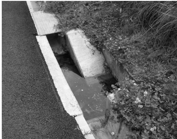
図 3.38 小動物が脱出できる側溝の例
