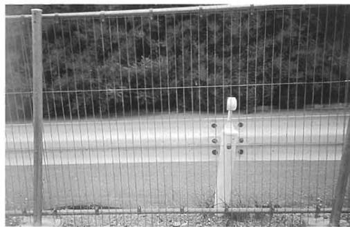
写真-1 縦目型フェンスの設置
