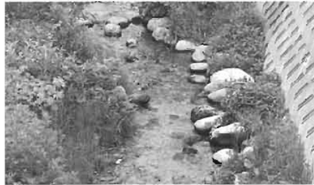
写真-5 自然河川を復元した河床（秋田自動車道）
