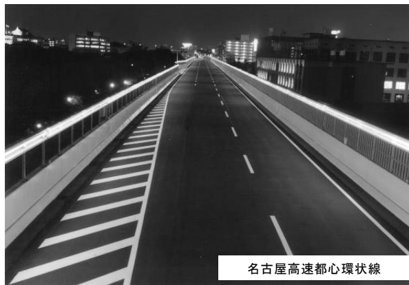
図 3.41 ヒメボタルへの影響に配慮した高欄照明
