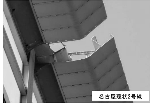
先端分岐型遮音壁
