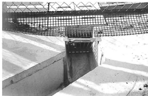
写真-2 フェンス下部からの侵入防止
