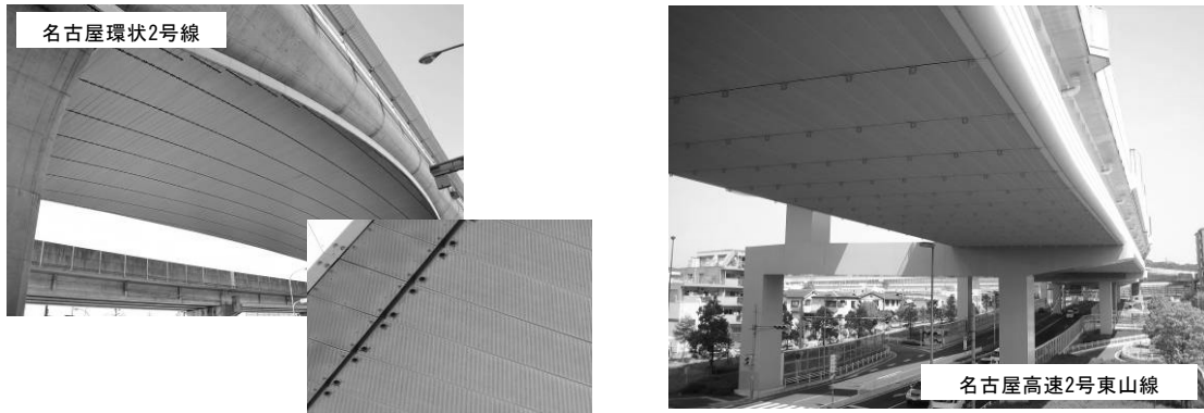
図 3.14 高架裏面吸音板設置例
