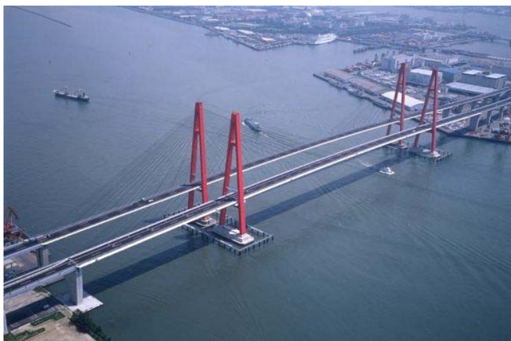
鉛直的形態:存在感:斜張橋
