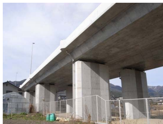
図 3.3.1 縦引き管の望ましい配置例
