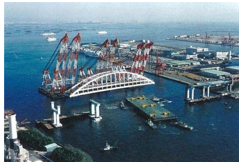
軸式特殊台車による架設工法
