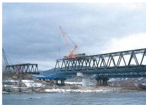
フローティングクレーン工法
