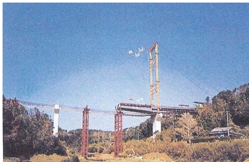
トラベラクレーン工法
