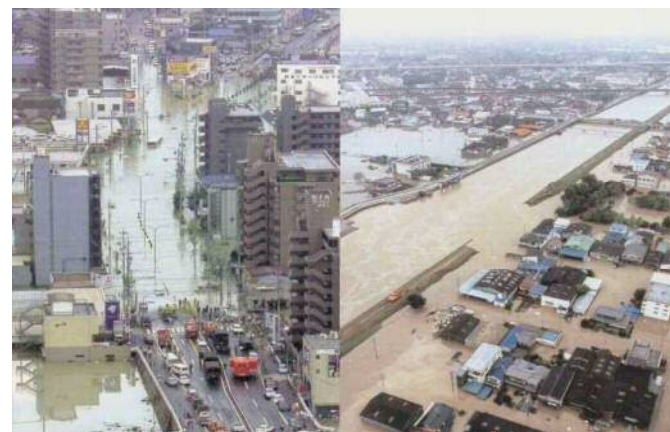
2000年9月の東海豪雨による被災状況
