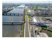
緊急輸送道路の整備 （一般県道平和蟹江線（蟹江町））
