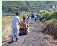
未舗装農道の舗装
