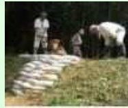
漏水箇所の補修
