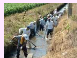
水路の泥上げ
