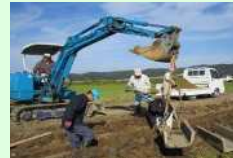
コンクリート水路の更新
