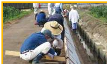
直営施工による水路補修作業
