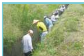
排水路の清掃
