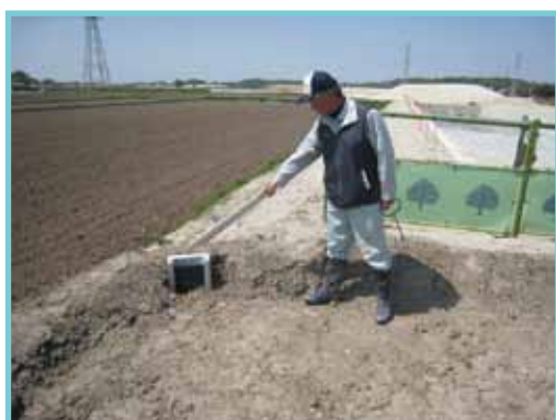
排水柵の設置
