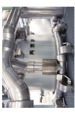
⑤再燃炉 (縦型円筒炉) 炭化炉から排出される熱分解ガスおよび乾燥排ガスをガス温度850℃以上滞留時間2秒以上の高温で完全燃焼させ、 NOx 排出量を低減させます。
