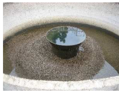
尾張東部（東郷）浄水場 着水井（平成20年2月）
