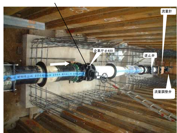
支援連絡管設置事例（西尾市）
