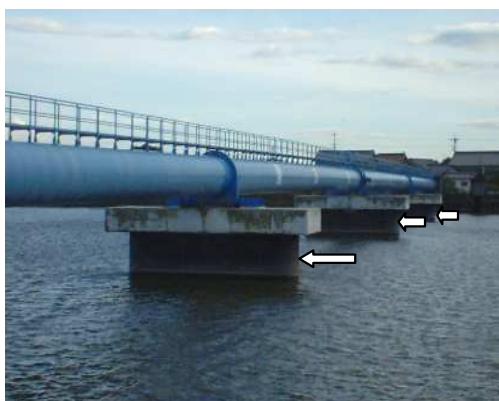
下部工耐震補強の事例(筏川第2水管橋)
