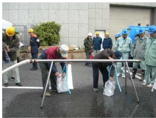
写真2 仮設給水栓による応急給水状況
