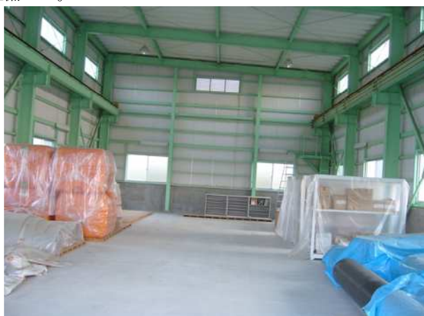
共用備蓄倉庫内観（東三河水道事務所）
