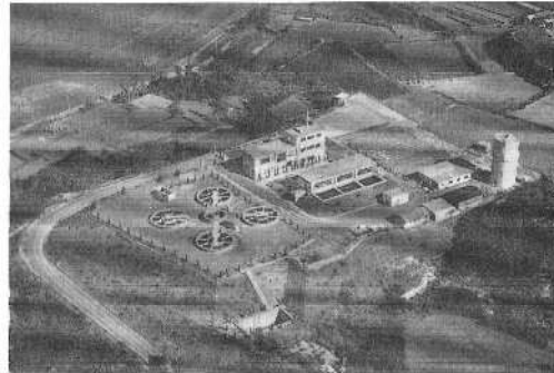
廃止された大谷浄水場
