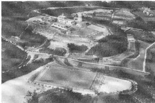
廃止された久米浄水場
