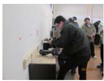
電動ドライバーを使って壁に柱木を取付
