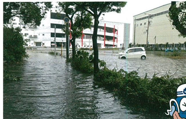
台風第21号による臨港道路(大阪市)の浸水の様子
