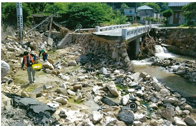
広島県東広島市の被災状況
