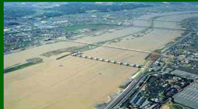
-8- 23号台風による洪水(平成16年10月)
