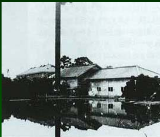
中江旧排水機場
