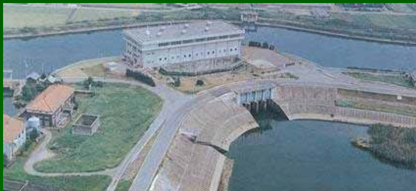
高須輪中排水機場
