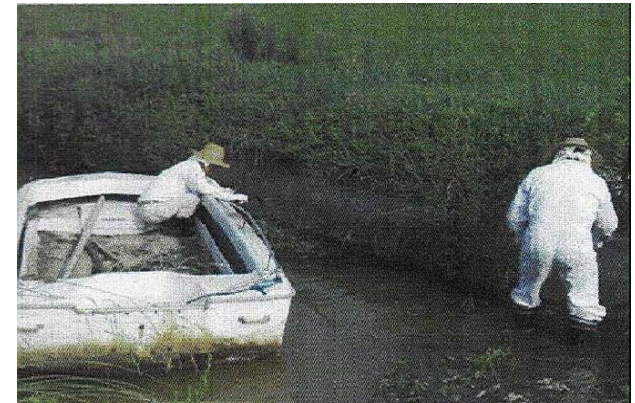
① 排水路の藻の除去作業
