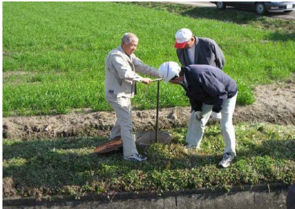
① パイプラインの清掃作業
