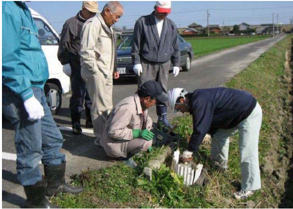
① 給水栓の分解清掃作業
