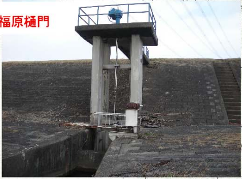
② 福原樋門(分水ゲート)
