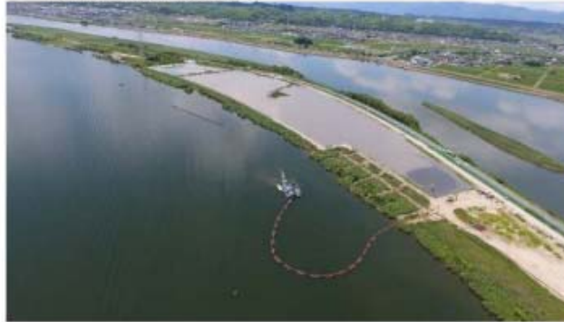
（現場写真：浚渫工）
