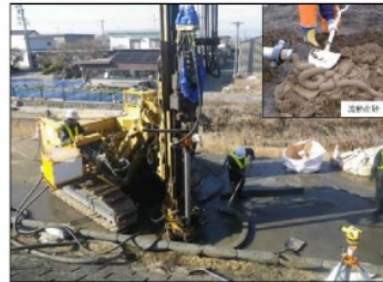
写真-3 堤防の耐震対策(砂杭)への活用
