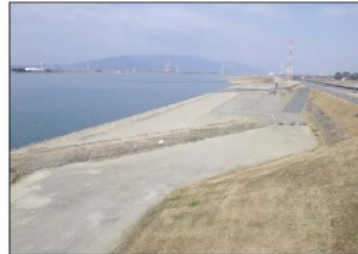
写真-4 堤防強化(高水敷整備)
