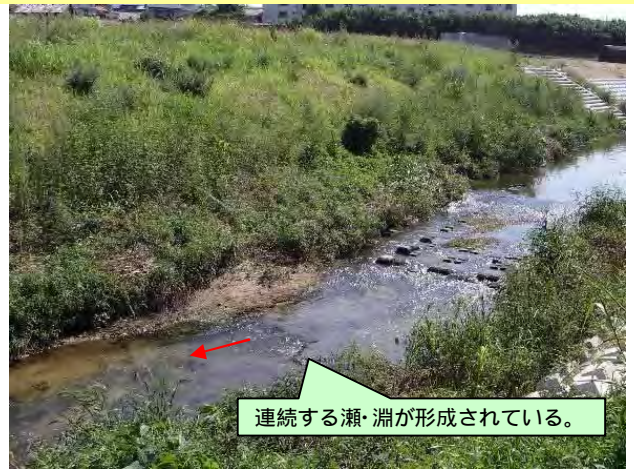
河床の状況(施工1年後)
