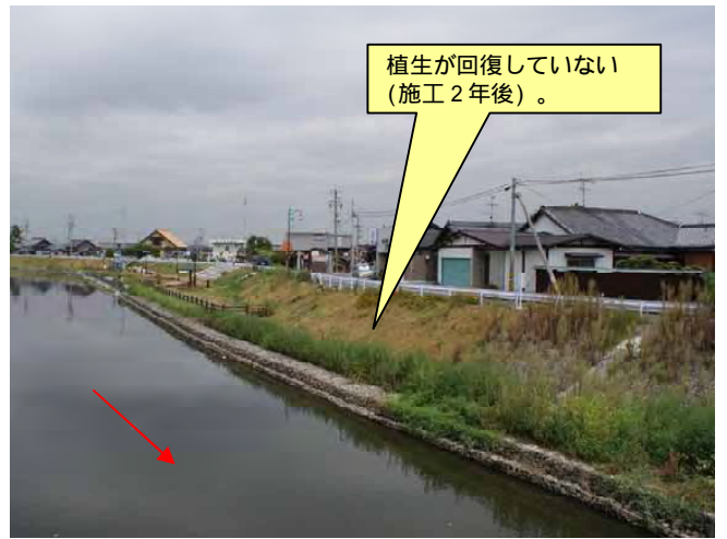
左岸側 露出した水際のふとんかご
