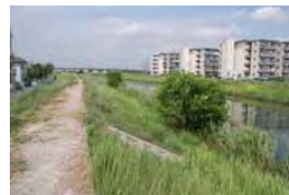
柳瀬橋上流左岸の階段
