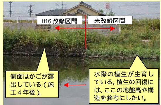
右岸側の未改修区間
