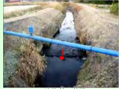
改修前の状況
