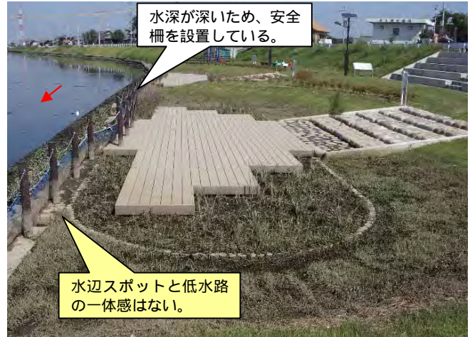
左岸側 水辺スポット内の菖蒲池
