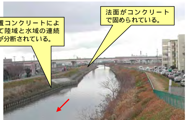
柳瀬橋から上流(改修前)
