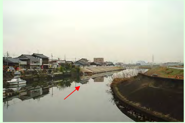
改修前の状況
