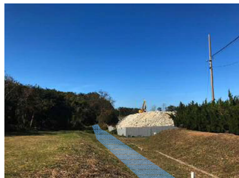
④ 鴨川排水路
