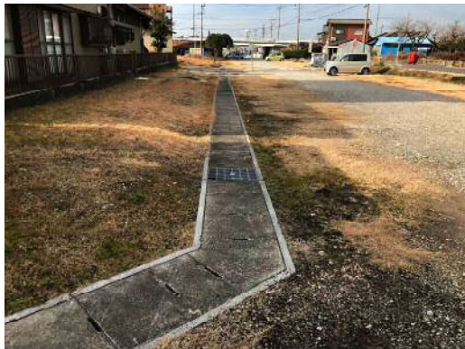
①排水ルート(側溝)
