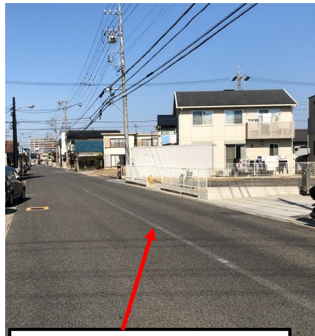
中央線を抹消し、外側線を設置。
