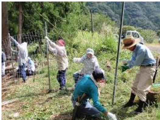
防止柵設置状況
