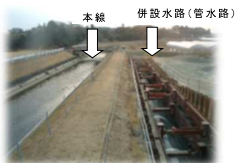
幹線水路の施工状況（豊川用水二期事業）
