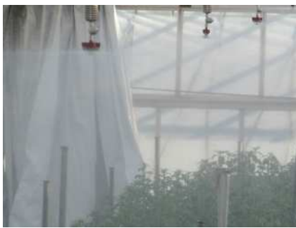
散水したキクハウス (スピネット赤色ノズル ：散水量 2L/分/ノズル)
