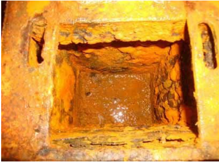
機器名:ガス貯留タンク
