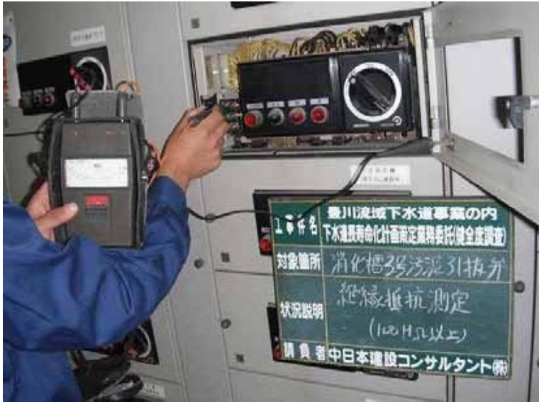
機器名:消化槽 3号汚泥引抜弁
