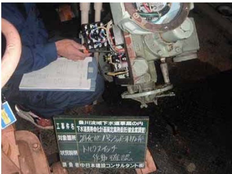
機器名:消化槽 1号汚泥引抜弁
