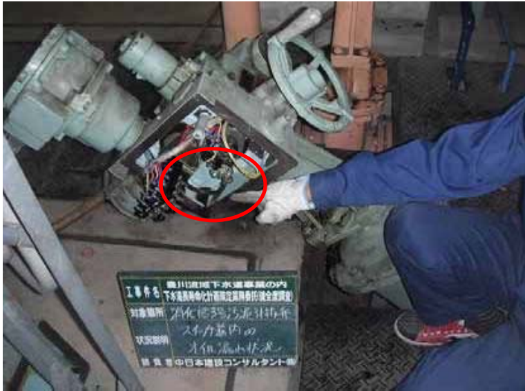
機器名:消化槽 3号汚泥引抜弁
