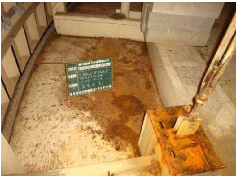
機器名:ガス貯留タンク
