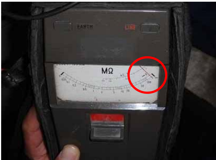
機器名:消化槽汚泥移送弁
