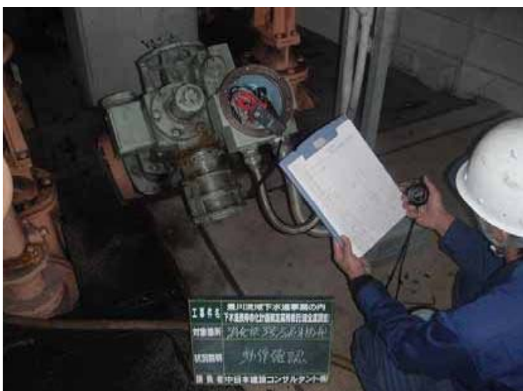
機器名:消化槽 3号汚泥引抜弁
