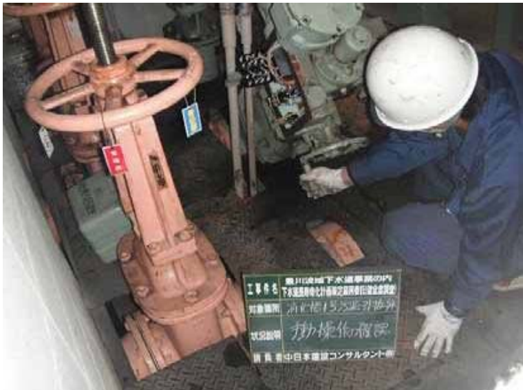
機器名:消化槽 1号汚泥引抜弁
