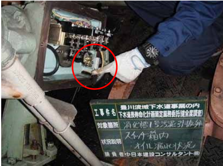
機器名:消化槽 1号汚泥引抜弁
