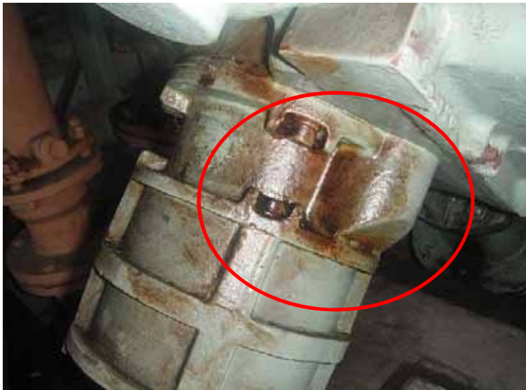
機器名:消化槽 3号汚泥引抜弁
