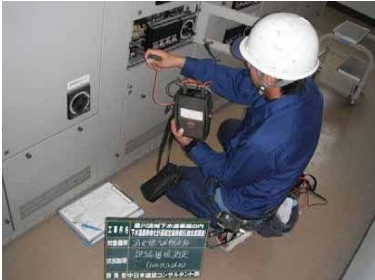
機器名:消化槽汚泥移送弁
