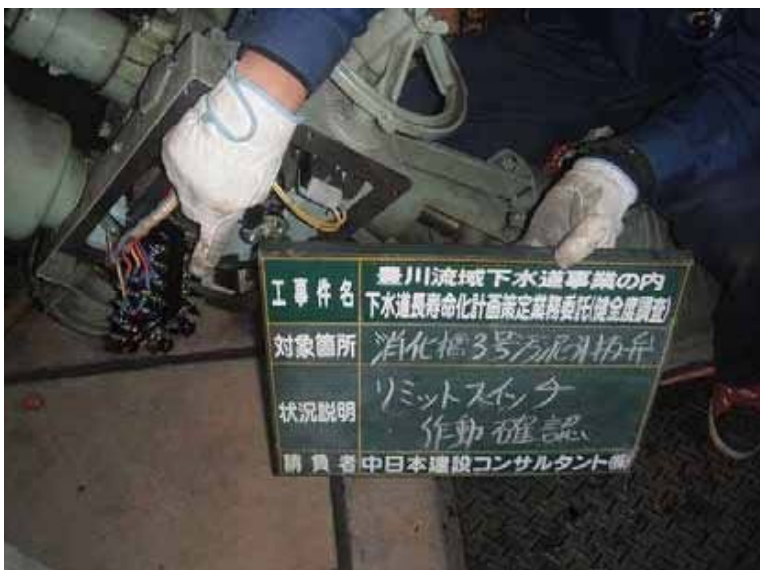
機器名:消化槽 3号汚泥引抜弁
