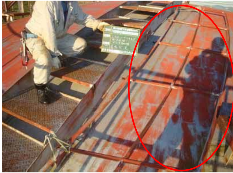
機器名:ガス貯留タンク
