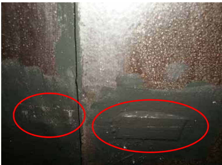
機器名:ガス貯留タンク
