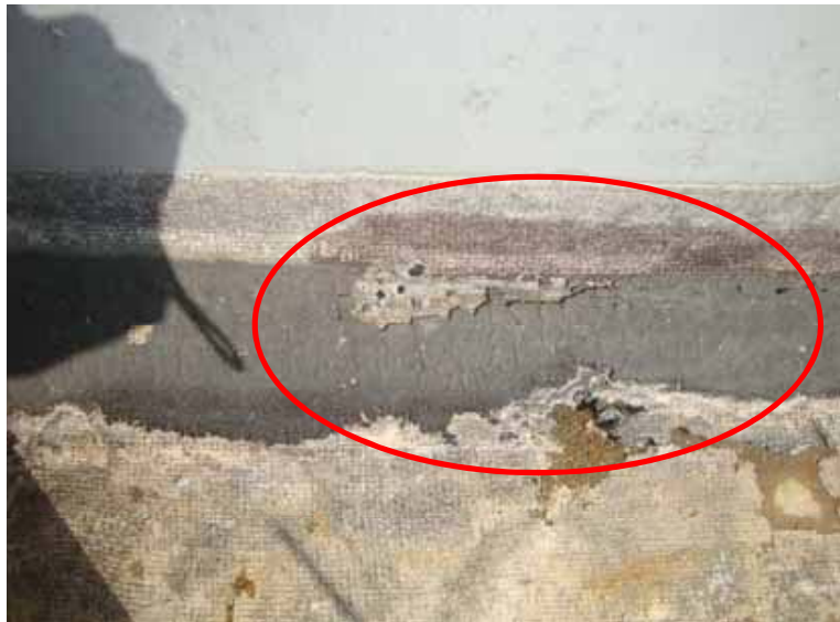
機器名:ガス貯留タンク
