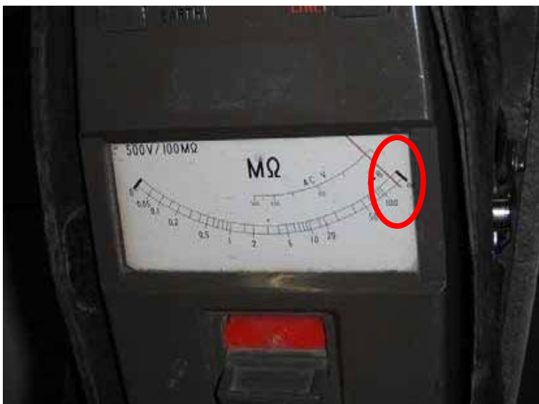
機器名:消化槽汚泥投入弁
