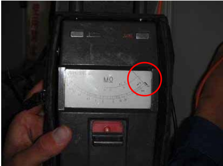
機器名:消化槽 2号污泥引抜弁
