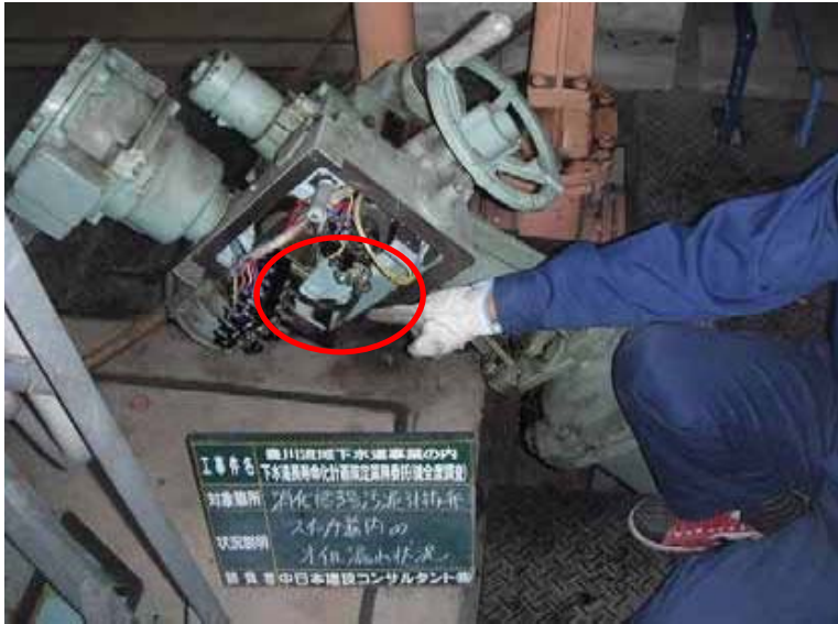
機器名:消化槽 3号汚泥引抜弁
