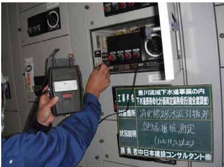
機器名:消化槽 2号汚泥引抜弁
