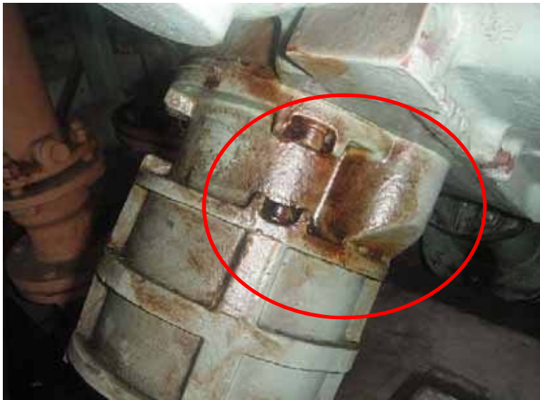
機器名:消化槽 3号汚泥引抜弁
