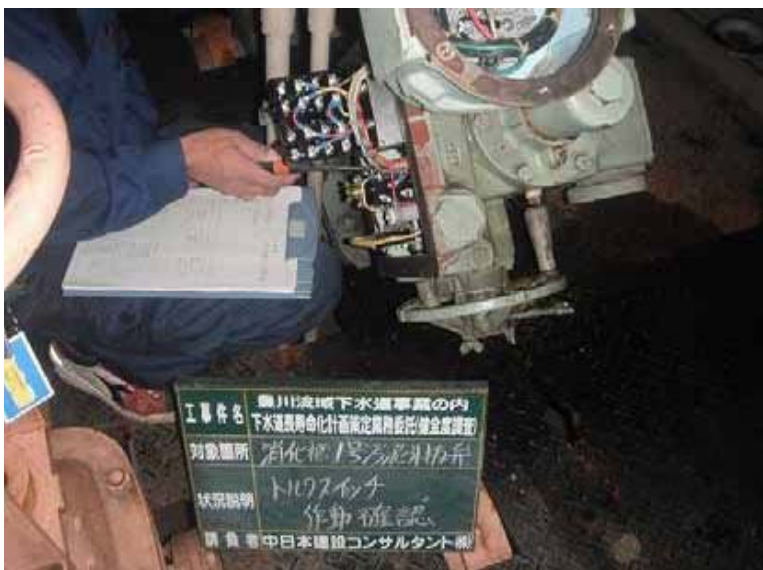
機器名:消化槽 1号汚泥引抜弁
