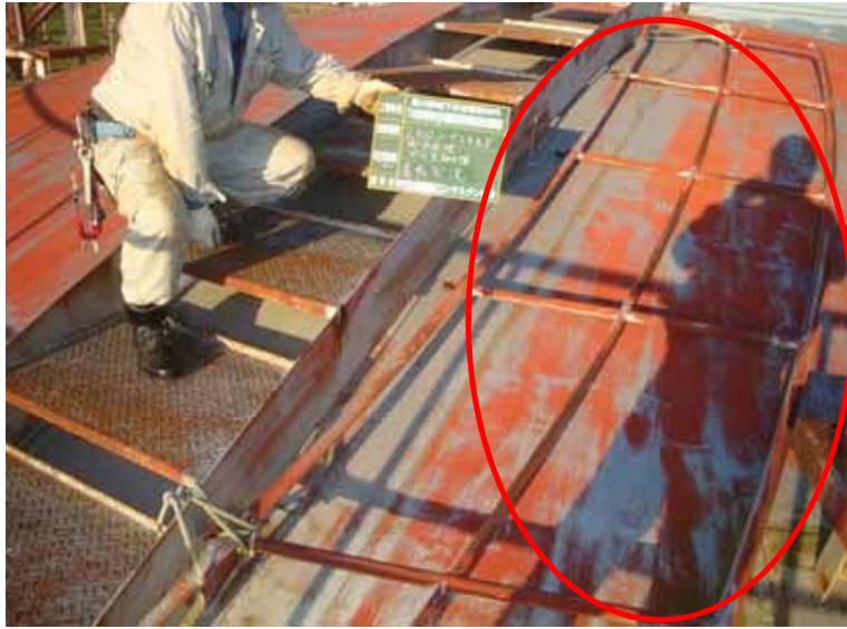
機器名:ガス貯留タンク
