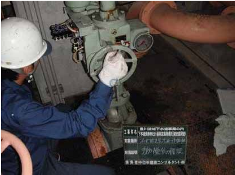
機器名:消化槽 2号汚泥引抜弁
