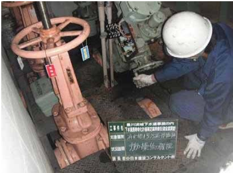
機器名:消化槽 1号汚泥引抜弁
