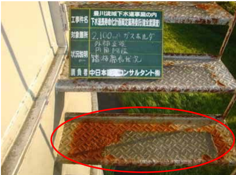
機器名:ガス貯留タンク
