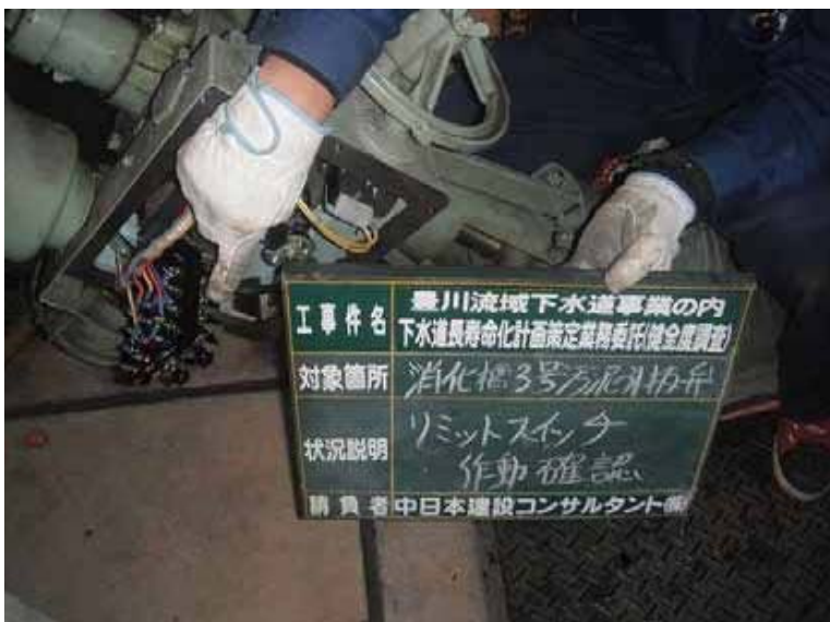
機器名:消化槽 3号汚泥引抜弁
