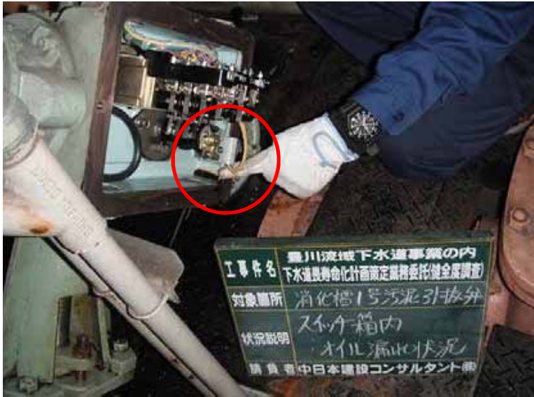
機器名:消化槽 1号汚泥引抜弁
