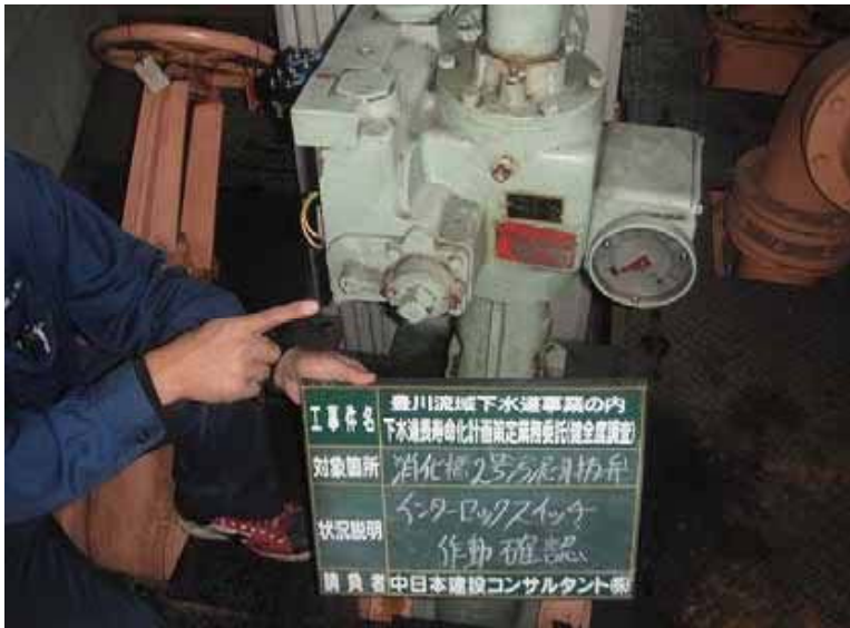
機器名:消化槽 2号汚泥引抜弁
