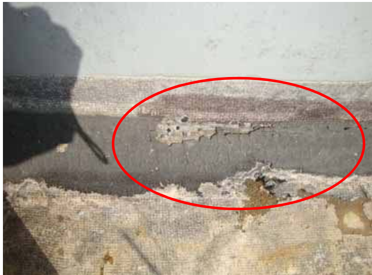
機器名:ガス貯留タンク
