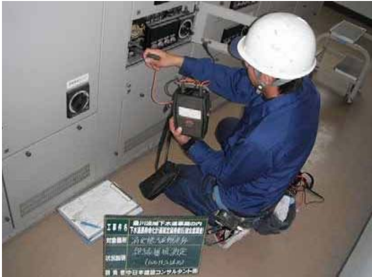
機器名:消化槽汚泥移送弁
