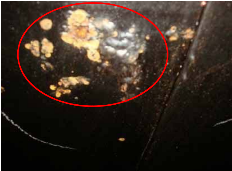
機器名:ガス貯留タンク
