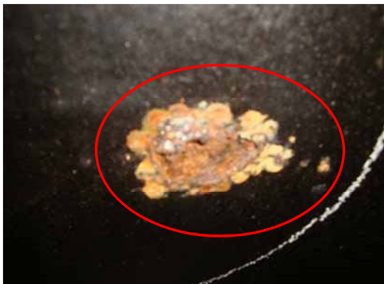
機器名:ガス貯留タンク
