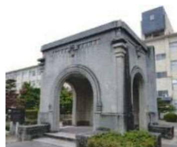
日本館車寄せ（南東から）
