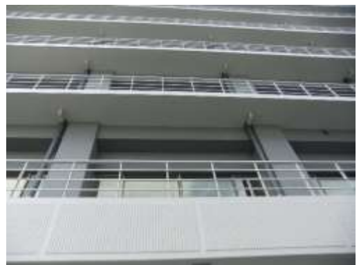
【災害拠点病院の耐震化】 （名古屋掖済会病院）
