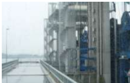
【日光川（水閘門）】
