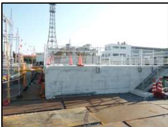
【変電機器の高上げ工事】
