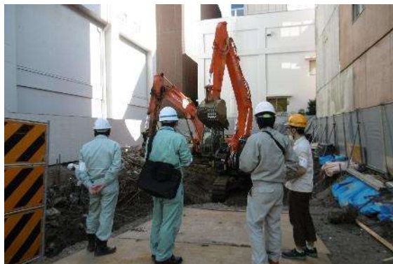
【解体工事現場における立入検査指導の様子】
