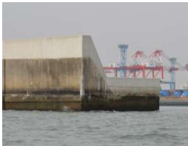
【高潮防波堤の改良】
