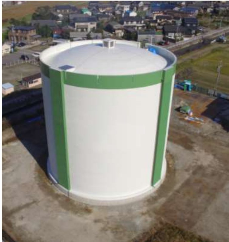
【西尾広域調整池1池】
