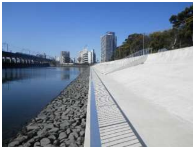
【防潮壁の地震・津波対策（鴨浦地区）】
