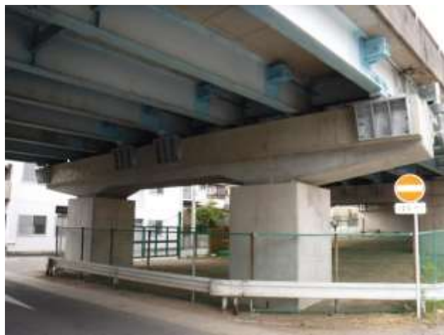
【一般県道西尾新川港線・常盤橋の耐震化】
