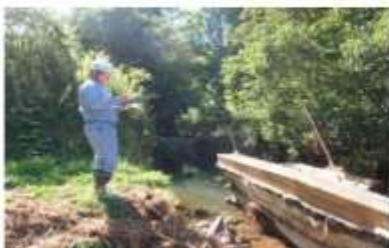
日田市松野川被災状況調査
