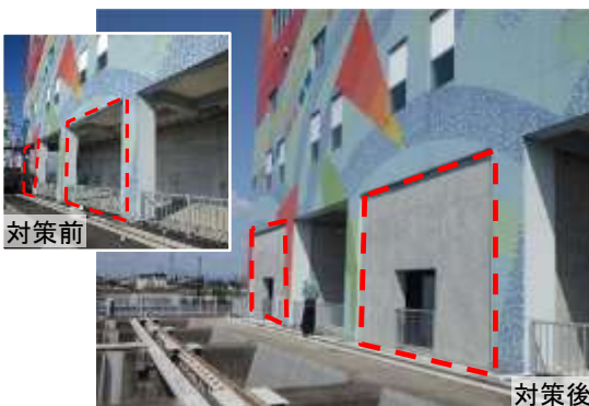
【排水機場の建屋の耐震化】
