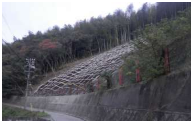
【治山施設の整備】
