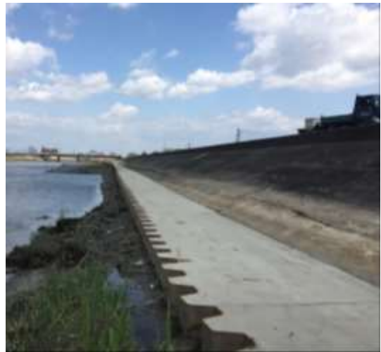
【猿渡川の耐震工事状況（完了）】
