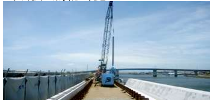
【一色漁港海岸の耐震工事状況】
