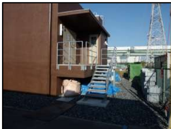
【変電所建屋の高上げおよび防水対策工事】
