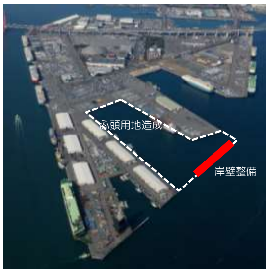
【金城ふ頭の耐震強化岸壁（新規）】
