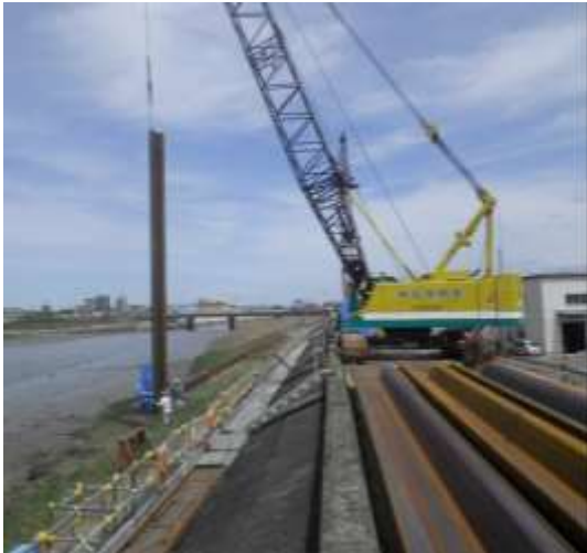
【猿渡川の耐震工事状況（矢板打設）】
