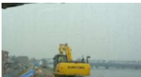
【天白川（耐震工事）】
