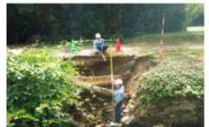
朝倉市梅の谷川被災状況調査
