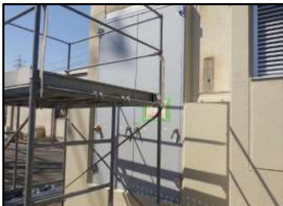
【変電所建屋の防水扉設置工事】
