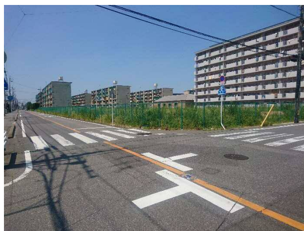
南方より調査対象地
