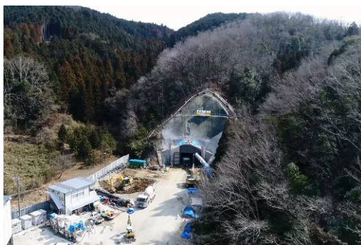
国道 301 号松平バイパス トンネル施工状況（豊田市）
