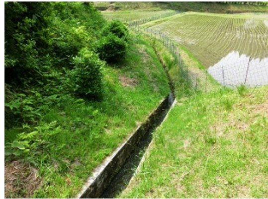
農地環境整備事業 敷島地区（豊田市） 排水路の整備状況
