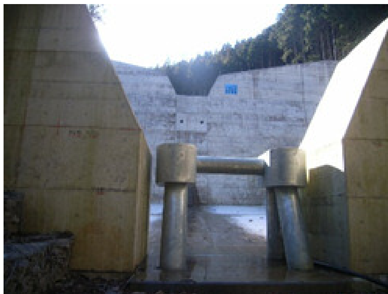
施設整備が概成した大千瀬川第10支川（東栄町）
