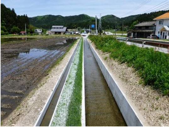
農地環境整備事業 川口地区（設楽町） 用水路及び排水路の整備状況
