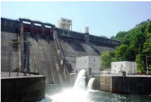
羽布ダム小水力発電所 （写真右の建物）
